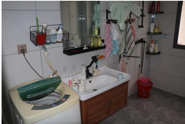
图 19 上、下水管道基本畅通，各种卫生器具基本完好
