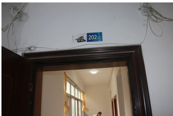
图 9 过梁完整牢固，无下挠、变形、裂缝
