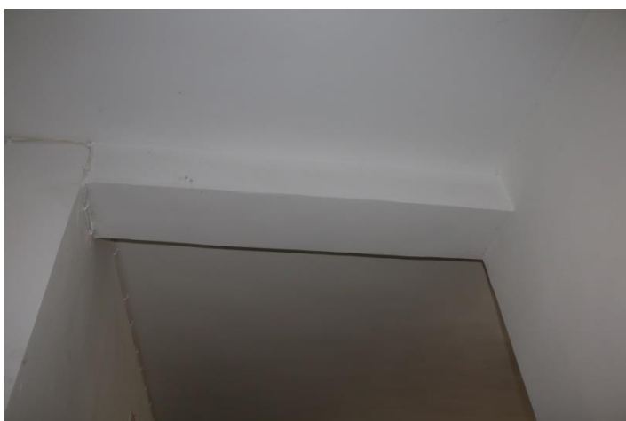
图 6 梁构件基本平直牢固、未见明显变形、裂缝。
