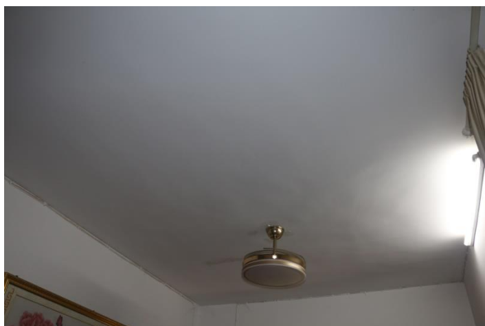
图 5 板承重构件完整牢固，无下挠、变形、裂缝
