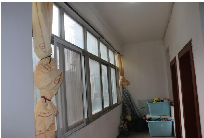
图 7 砌体自承重墙基本平直牢固，未见明显倾斜，变形
