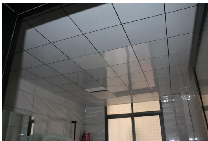
图 17 顶棚完整牢固，无变形、下垂
