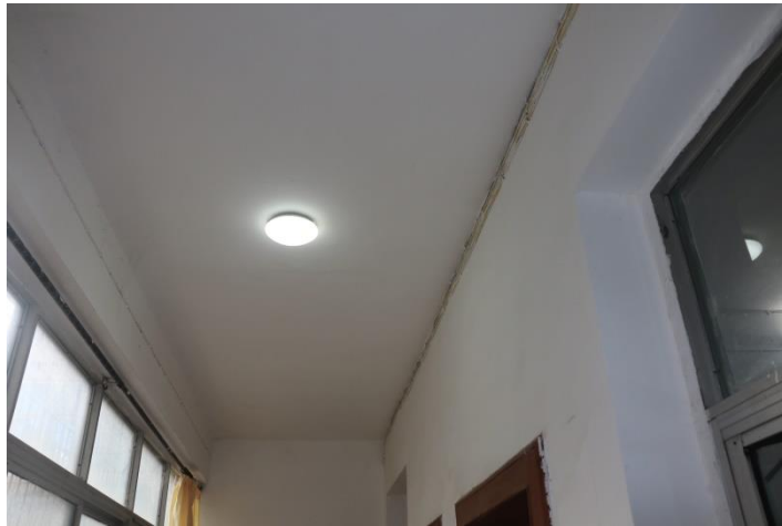
图 18 电器设备、线路、照明装置完好
