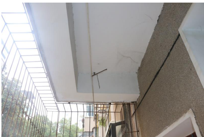
图 8 挑梁完整牢固，无下挠、变形
